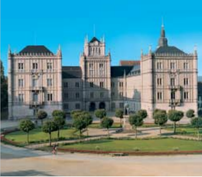
Main façade of the Ehrenburg on the Schlossplatz
